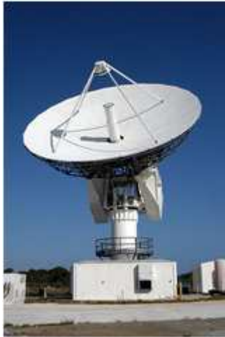
Figura 2-1: Antena para comunicaciones por satélite en banda C de 15 m de diámetro
